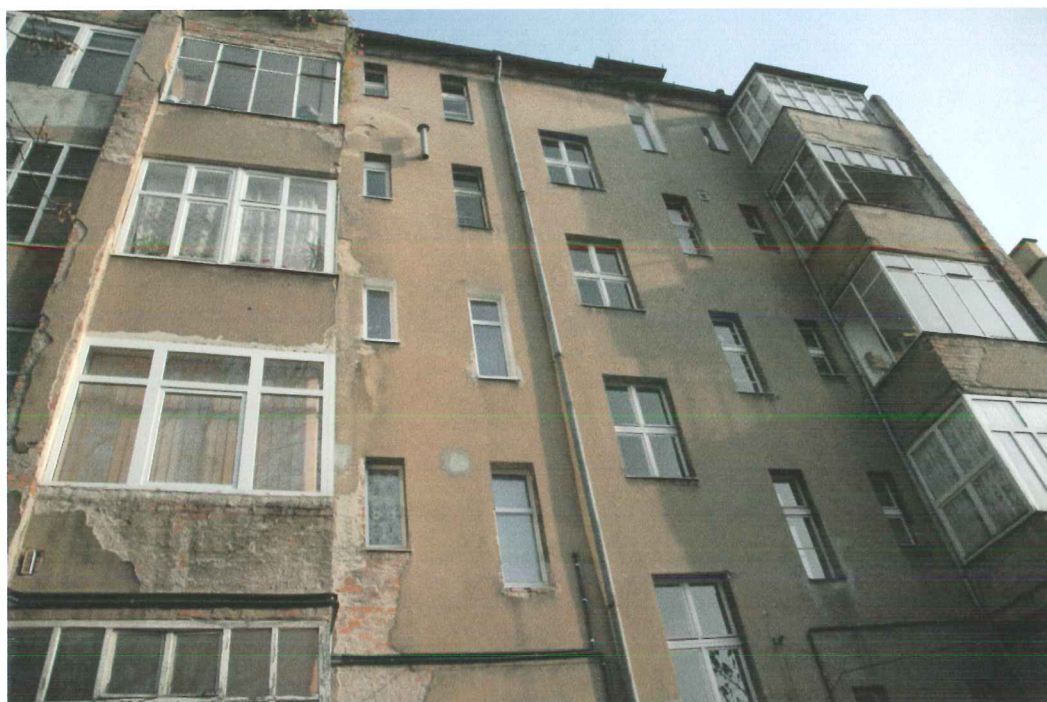
Fot.7. Budynek nr 78, elewacja tylna. Widoczne są ubytki tynków oraz zabudowa balkonów.
