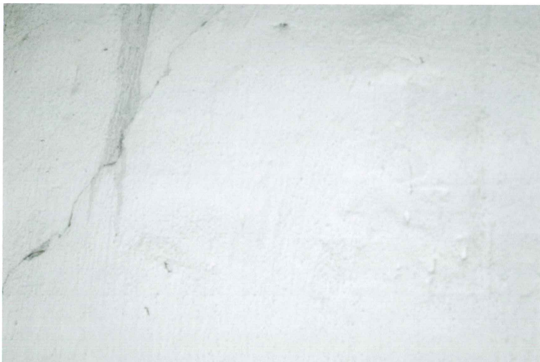
Fot. 20. Budynek nr 74. Rysy w ścianie szczytowej na poziomie strychu.
