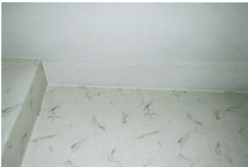
Fot.3. Budynek nr 78, mieszkanie nr 6. Rysy na suficie przy ścianie szczytowej.
