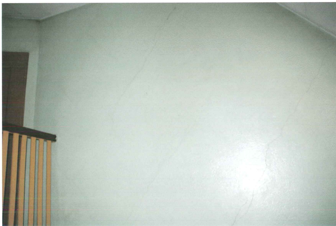
Fot.18. Budynek nr 74. Rysy w ścianie klatki schodowej przy wejściu na strych.
