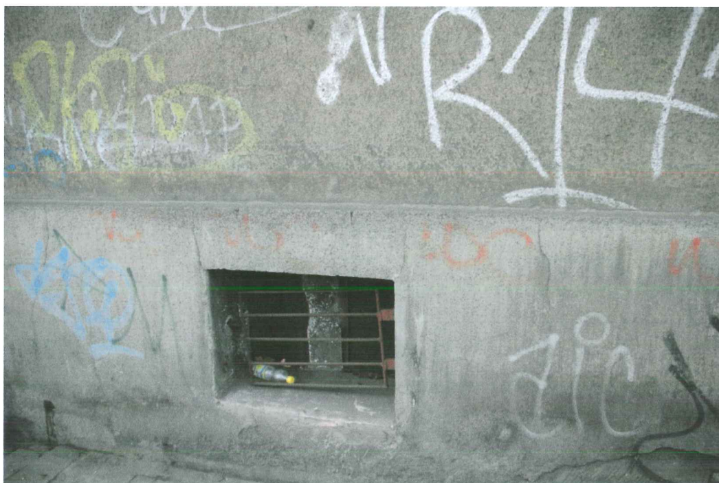
Fot.9. Budynek nr 78. Zarysowania w dolnej części elewacji frontowej.
