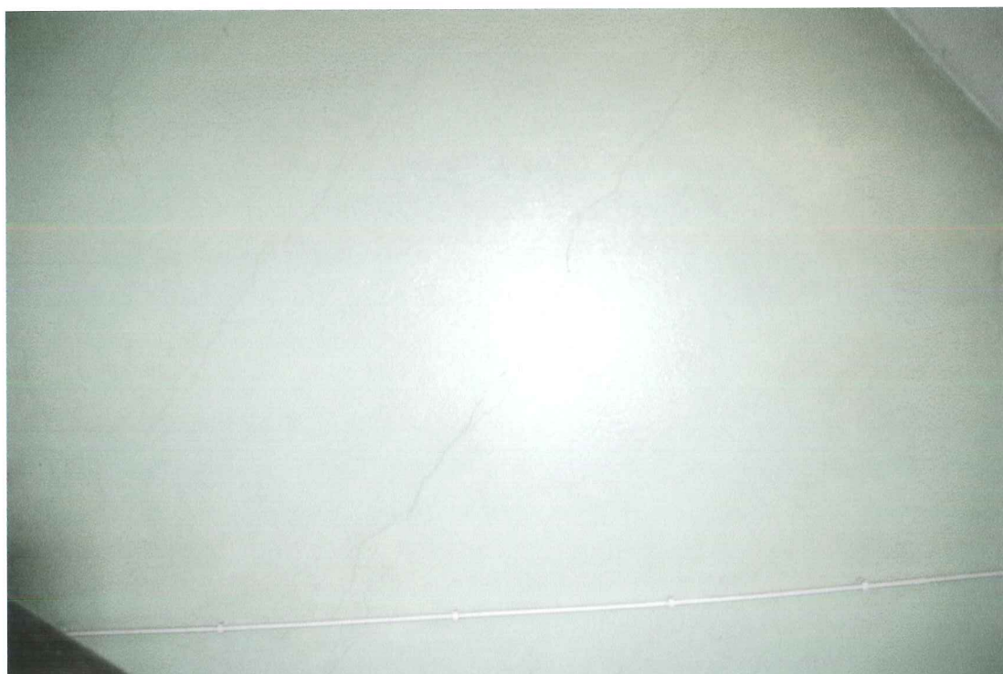
Fot.17. Budynek nr 74. Mieszkanie nr 3, rysy na ścianie kominowej.
